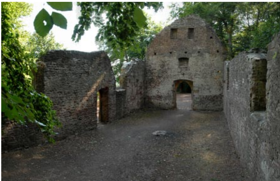
174 ◀ Denzlingen. Die Severin-Kapelle auf dem Mauracher Berg. Blick von Nordosten in Richtung Südwesten.
